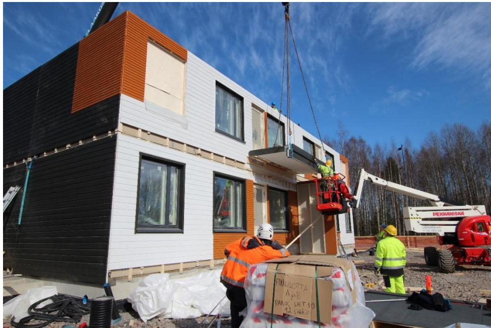
Kuva 6. Tilaelementtirakentamista. Parvekkeen laatan asennus käynnissä.
