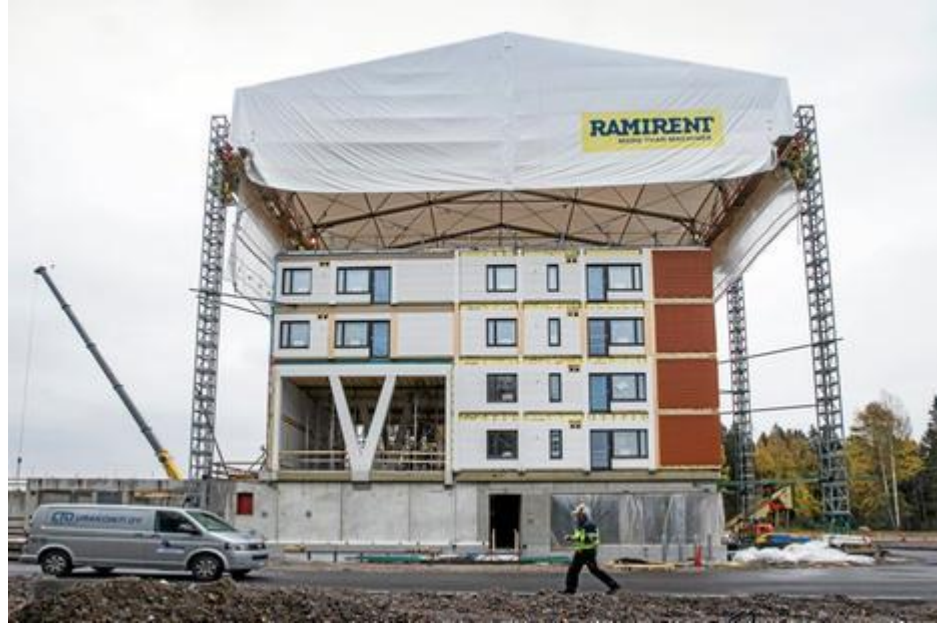
Kuva 2. Puukerrostalon sääsuojausta. Kohteessa käytössä Gibson Tower, jossa yhdistyy sääsuojaus sekä nostokalusto.
